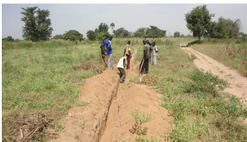
Creusement des tranchées de l'adduction d'eau de M'Bétite
