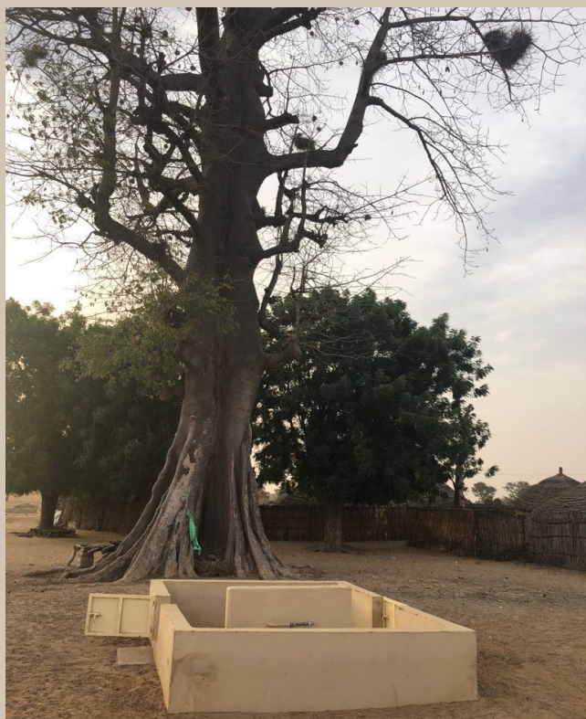
Adduction de Bak Sitor réalisée début 2022. Un muret la protège de la divagation et de la contamination des animaux
